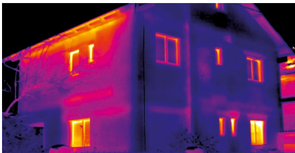
Gebäudeanalyse: Wärmeverluste, Baufeuchte und Schimmel aufspüren.
